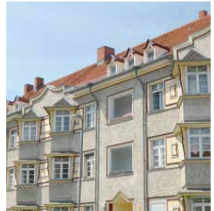
Genossenschaftlicher Wohnungsbau Spandau Zeppelinstraße.
