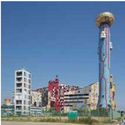
Müllverbrennungsanlage in Osaka von Hundertwasser
