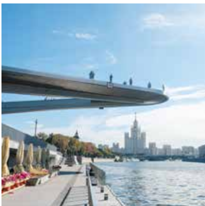
Moskau, Sarjadje-Park, Brücke über der Moskwa
